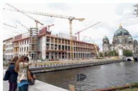
Noch überwiegt auf der Baustelle eine eher triste Fassade, doch schon bald soll das einstige Hohenzollern-Schloss wiedererstehen. Foto: dpa
